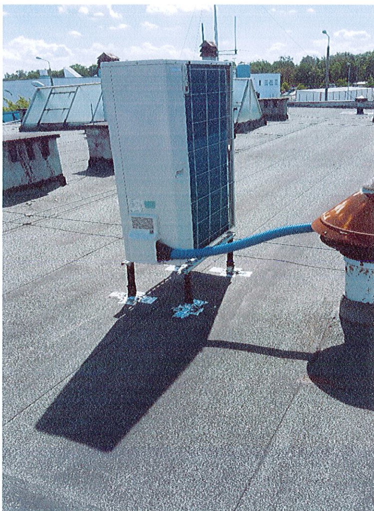
ryc. Widok na jednostkę klimatyzacyjną i świetliki dachowe, wymagające wzmocnionej ochrony odgromowej
