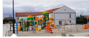
Baruchowo. Budowa Wielopokoleniowego Centrum Aktywności Rodzinnej na finiszu
